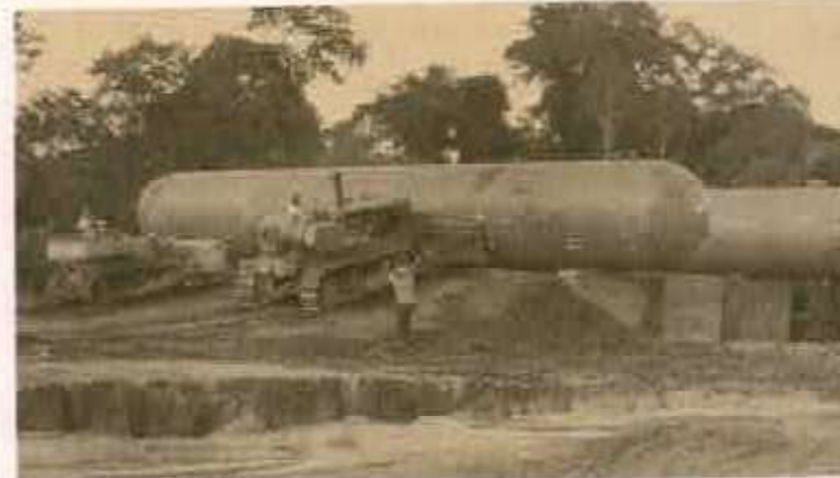
Na falta de guindastes, o assentamento com tratores.
