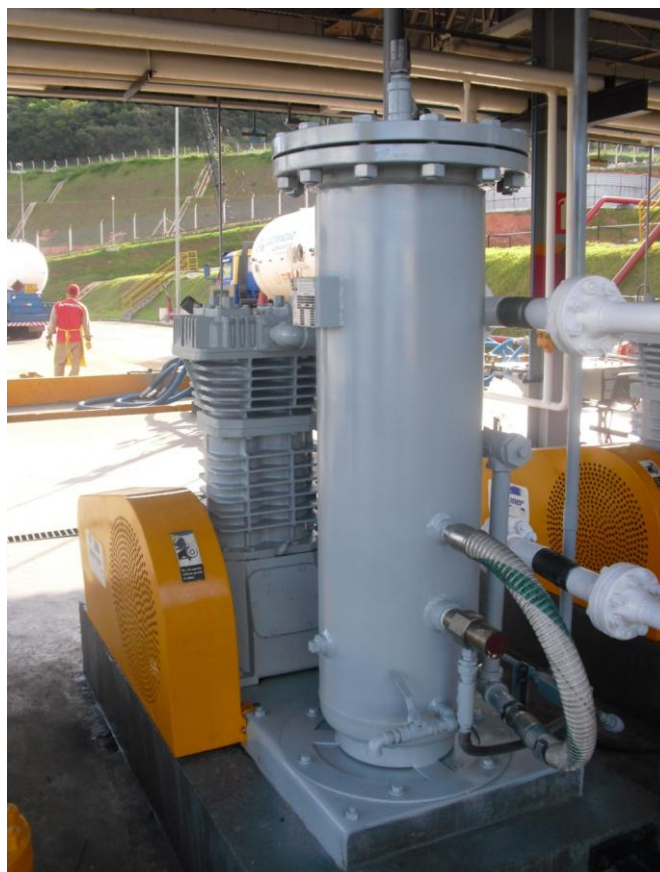
Fig. 6 – Compressor em uso.
