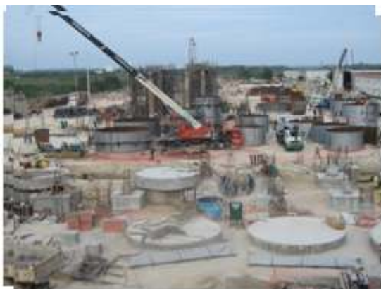
Figura 1: Fotos da obra na fase de ampliação da Bahia Pulp
