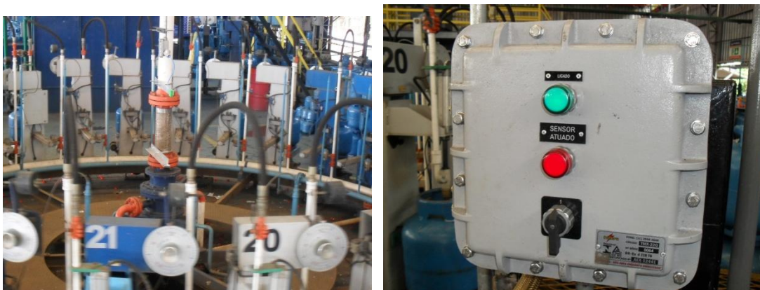
Fig. 4 – Equipamento em uso
