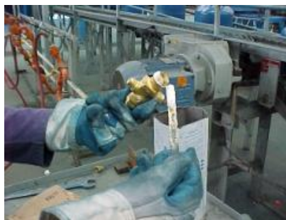
Fig 2 – Colocação de vedante na rosca da válvula.
