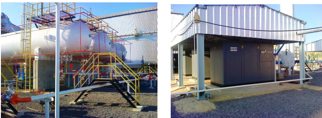
FIGURA 10. Centrais de GLP e ar comprimido na Siderúrgica Votorantim
