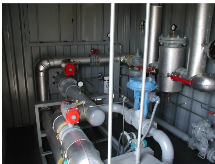
FIGURA 4. Misturador com apenas válvula controladora de ar comprimido
