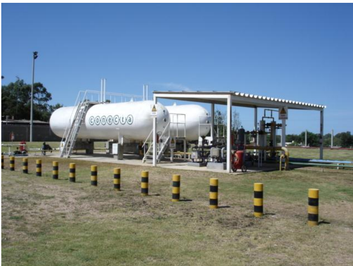
FIGURA 8. Central de GNS na empresa CONECTA.
