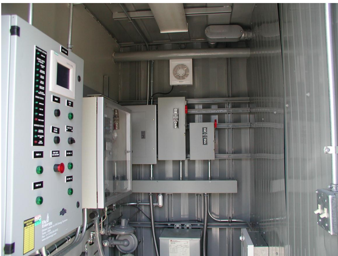
FIGURA 5. Sala de controle do misturador, com Wobbímetro e PLC.
