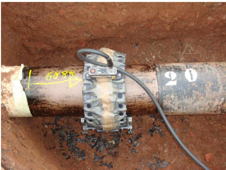
Figura 7 – Anel para tubulação de 8”
