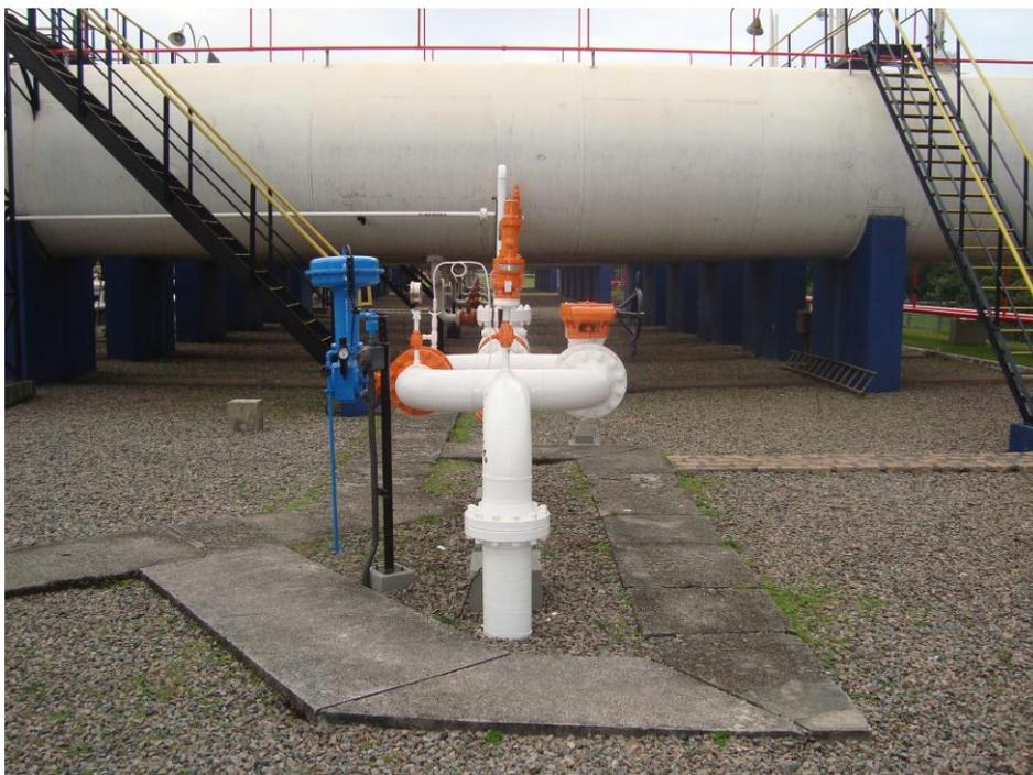
Figura 3 – Conjunto de Válvulas de Controle.
