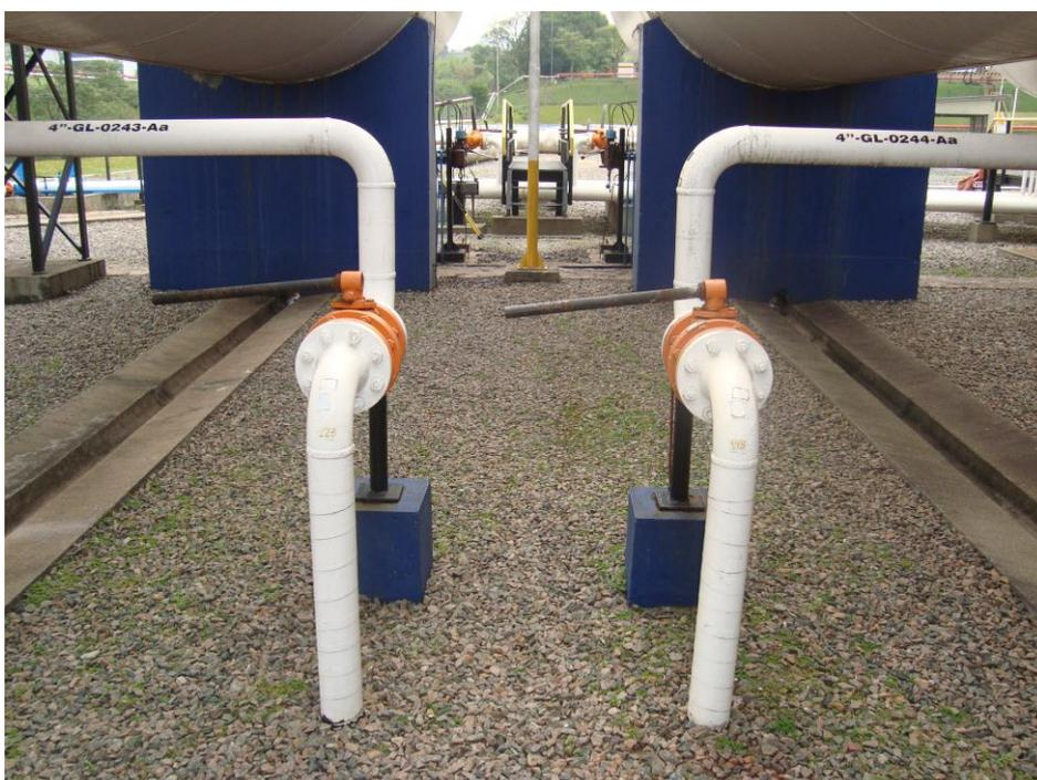
Figura 2 – Subidas em 4" para os tanques.
