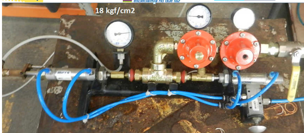
Figura 6 – teste de estanqueidade conforme a NBR13523
