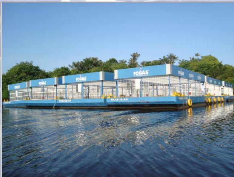
Figura 2 – Balsas de armazenamento de recipientes de Gás LP.
