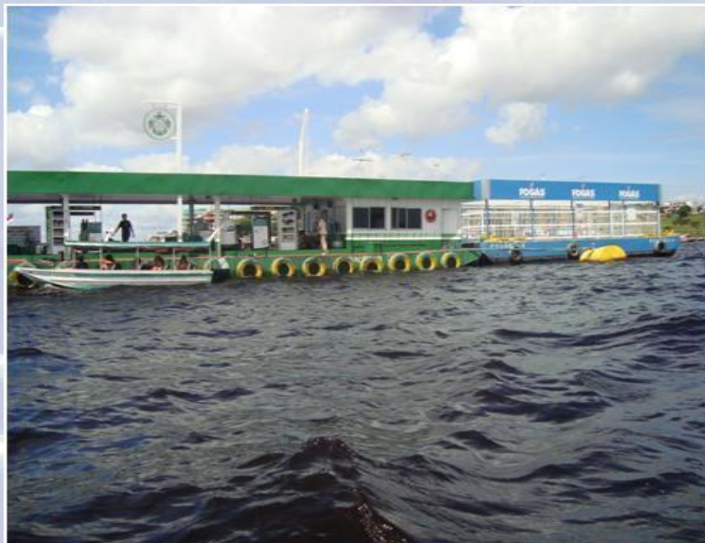
Figura 3 – Balsas de armazenamento de recipientes de Gás LP.
