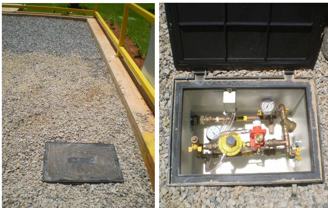
Figura 8 – Instalação em um canteiro.
