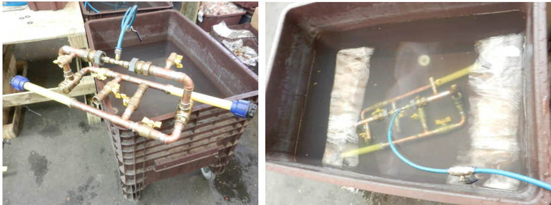
Figura 4 – Teste de estanqueidade realizado na tubulação.
