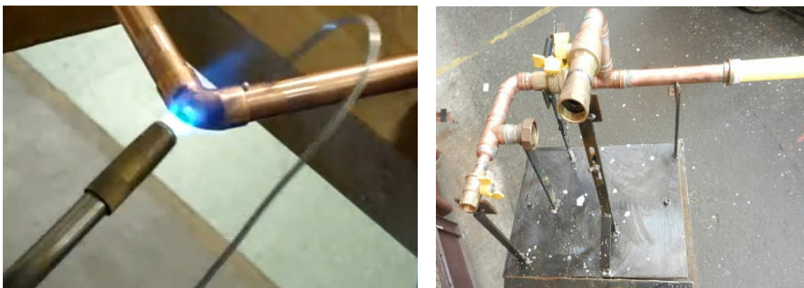
Figura 3 – Soldagem das tubulações do conjunto de regulagem enterrado.
