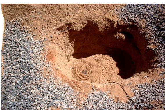
Figura 9 – Escavação para inspeção em um vaso enterrado para colocação do sensor de EA na geratriz superior
