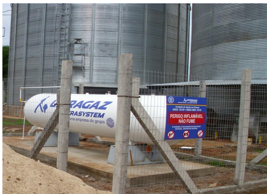
Figura 1. Sistema de armazenagem instalado para atender o silo secador.
