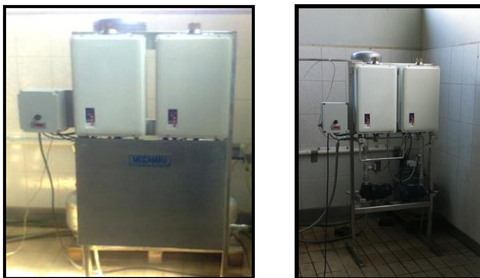
Fig. 2 – SKID para aquecimento de água
