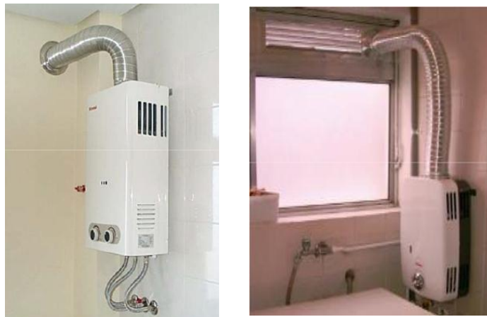
Fig. 1 – Aquecedores de passagem convencionais
