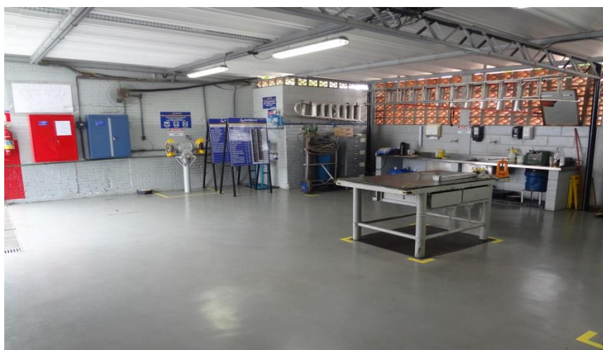
Figura 6 – Espaço de trabalho Limpo e organizado (Após a reforma)
