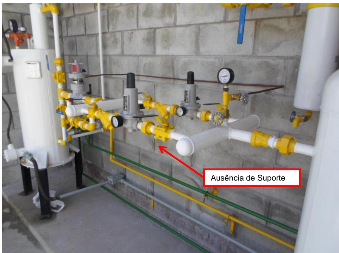
Fig. 2: Visão geral do abrigo sem suporte
