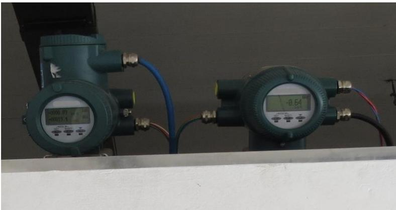
Figura 10 - Medidores mássicos de vazão de gás (esquerda) e de água (direita)
