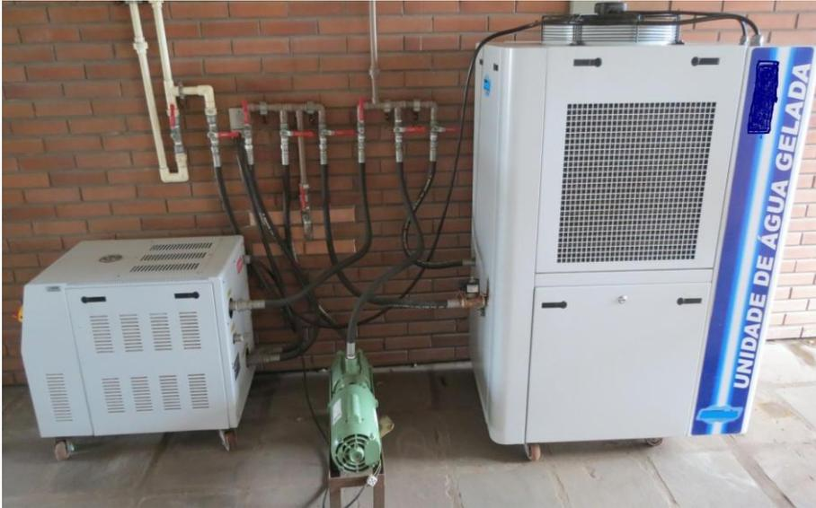
Figura 11 – Sistema de resfriamento de água
