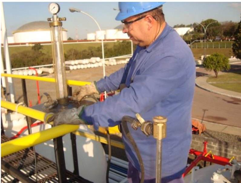
Foto 8: Termodensímetro Acoplado a VCM totalmente estanque
