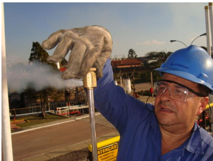
Foto 6 – Abertura da VCA através do regulador sem necessidade de girar o conjunto.
