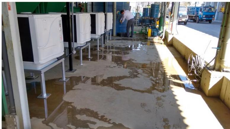
Bombas de calor instaladas em linha na unidade de Barueri, para um volume de 3.000 litros / hora, necessidade de 4 equipamentos.
