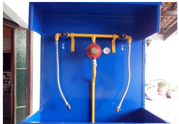
Figura 5: Fixação do coletor
