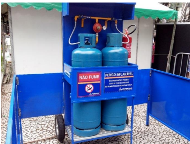
Figura 4: Instalação das placas de sinalização
