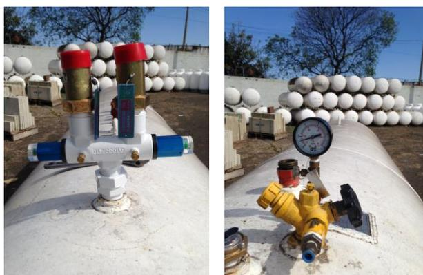
Figura 8 – Montagem da válvula multi-point em recipiente estacionário Ultragaz
