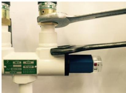
Figura 7 – Troca da válvula de segurança na válvula multi-point
