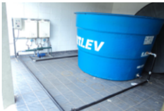
Sistema de aquecimento com circulação de água através de uma bomba em uma caixa de água.
