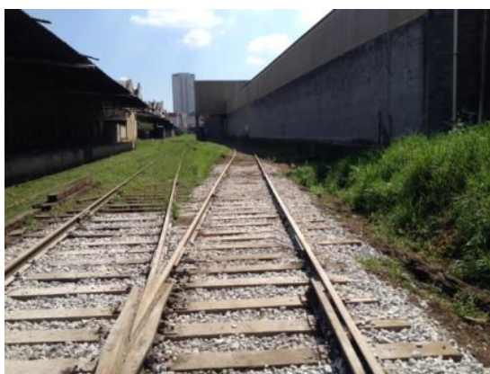
Figura 5 - Linha férrea após a limpeza
