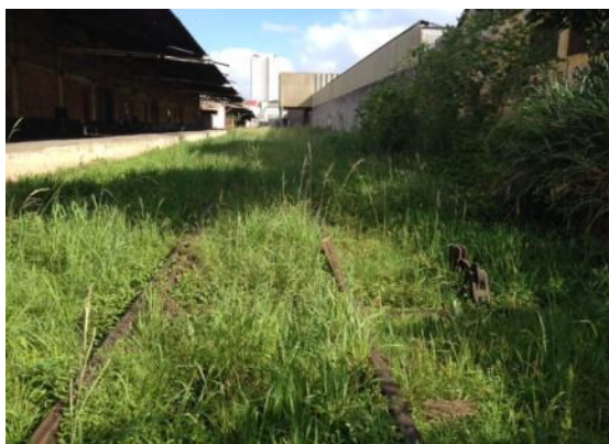
Figura 4 - Linha férrea antes da limpeza
