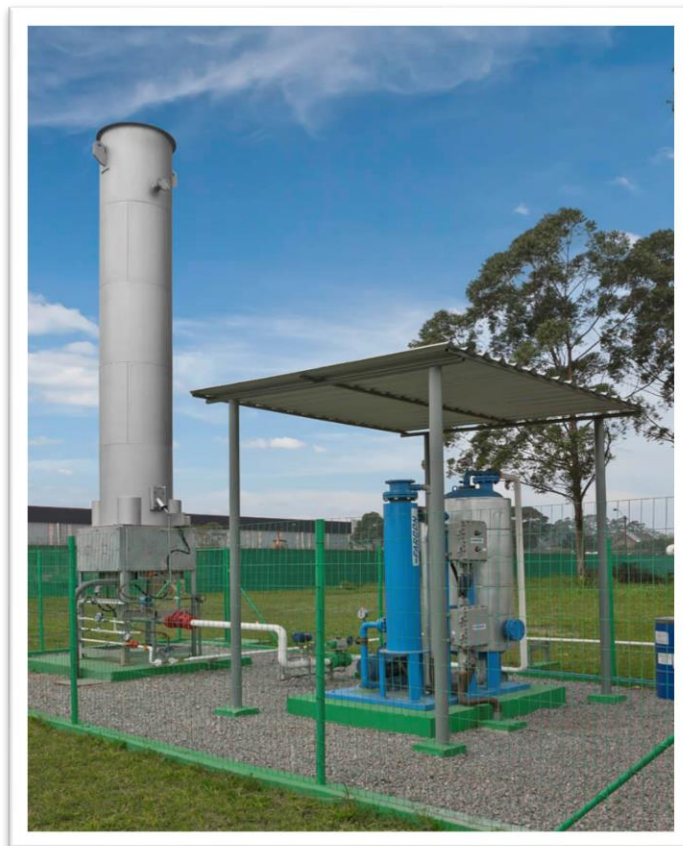
Figura 3. Instalação do processo de regeneração de peneiras moleculares.
