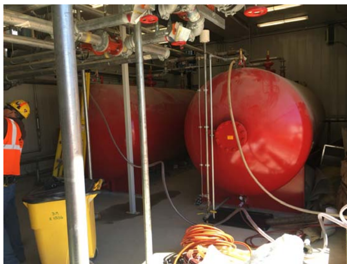
Figura 7 - Tanques de Agente Encapsulador F-500, 10,000 Litros cada
