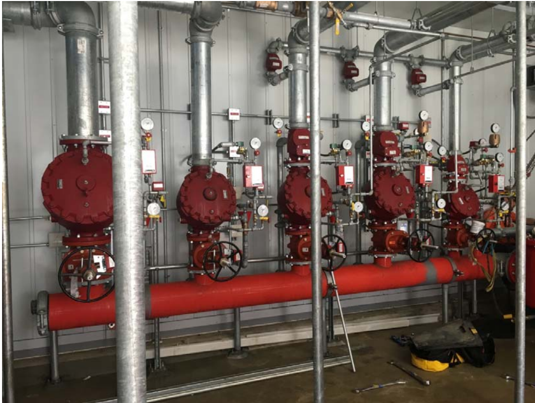
Figura 6 - Conjunto de válvulas para sistemas de Agente Encapsulador F-500
