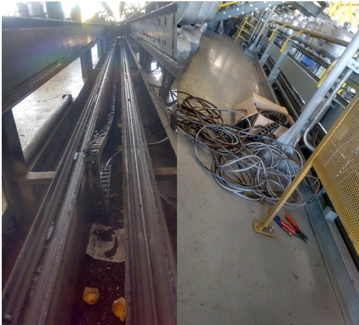
Figura 1- Troca de cabos e porta cabos em uma lança instalada na filial da Copagaz em Ibirité - MG
