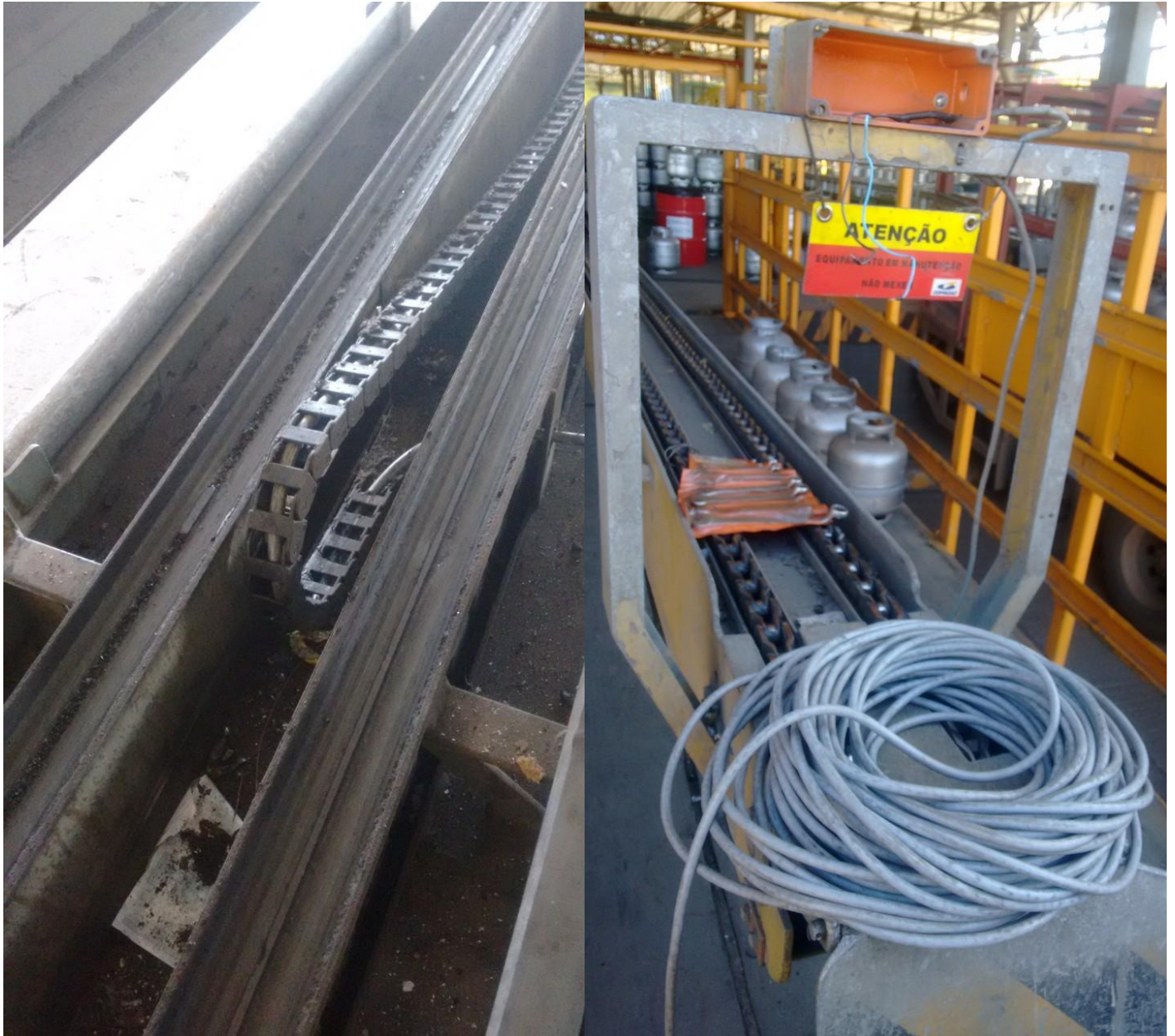
Figura 2 - Novos cabos e porta cabos sendo instalados uma lança instalada na filial da Copagaz em Ibité - MG
