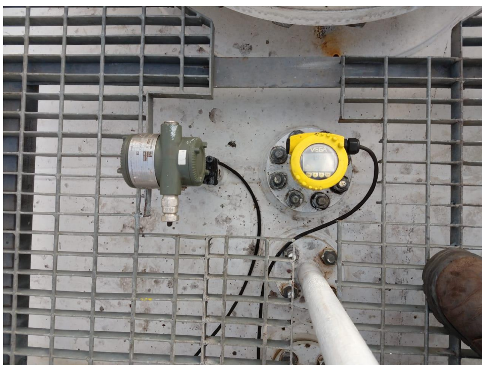
Figura 13 - Transmissores de nível e pressão nos topos dos vasos
