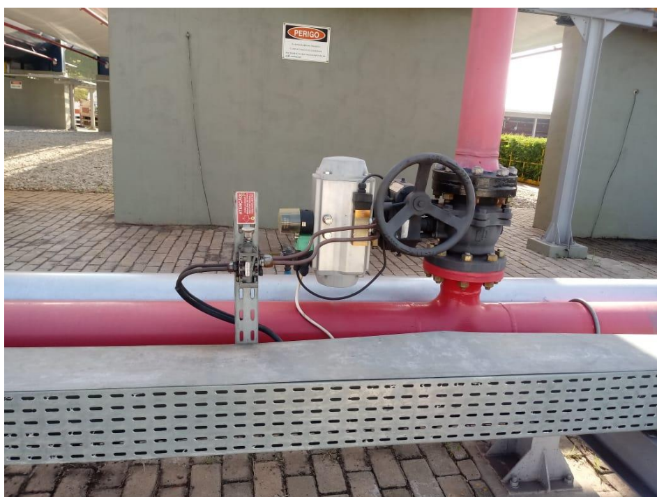
Figura 15 - Válvulas de nebulização com 3 sistemas de acionamento
