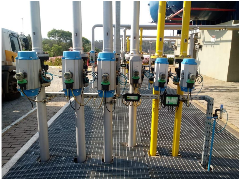
Figura 11 - Válvulas do header e remota Profibus DP
