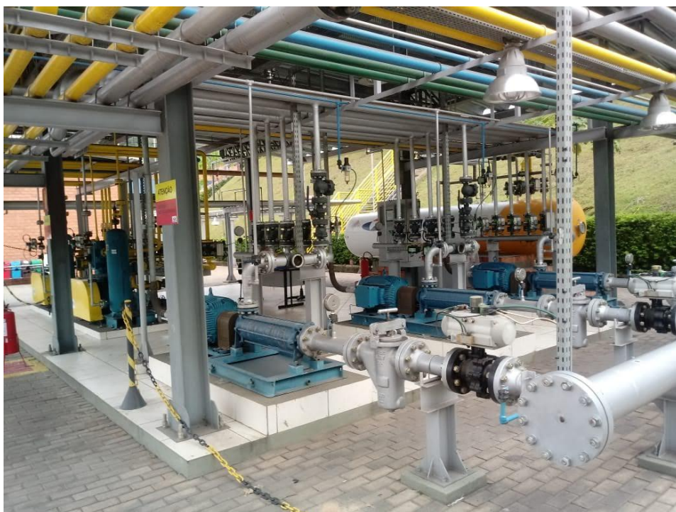
Figura 5 - Vista da casa de Bombas
