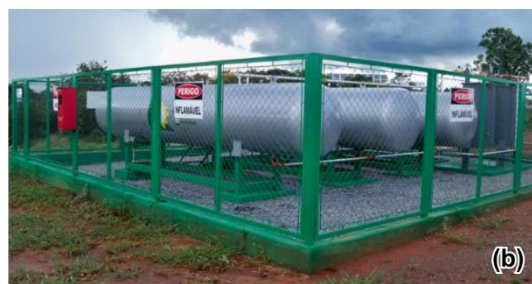
Figura 2 – (a) - carretas de acetileno. (b) visão de uma central típica de GLP com o dobro da capacidade de armazenamento de combustível.
