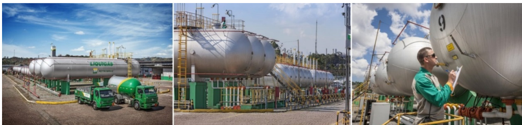
Centro Operativo Liquigás (Unidade Operacional)
