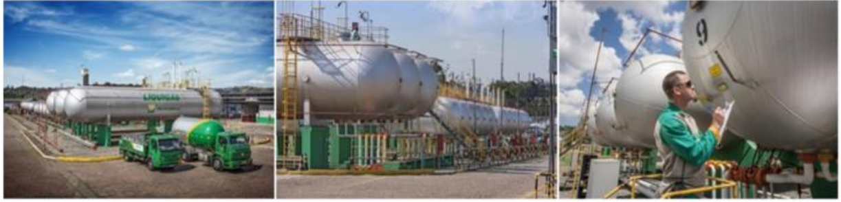
Centro Operativo Liquigás (Unidade Operacional)
