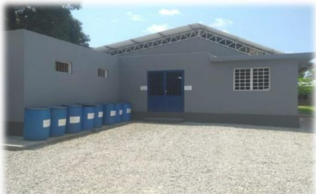
Imagem Frontal da Recuperadora Roso
