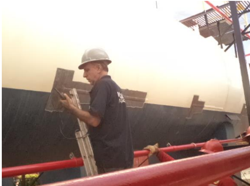
Figura 100 – Ensaio de ultrassom dos encontros soldados.
