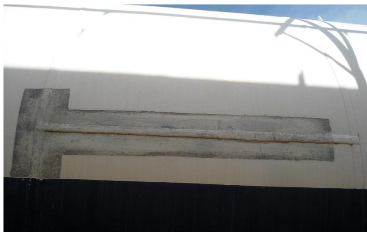
Figura 6 – Remoção da tinta dos encontros soldados e soldas longitudinais.
