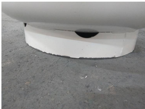
Figura 3- Pintura danificada
