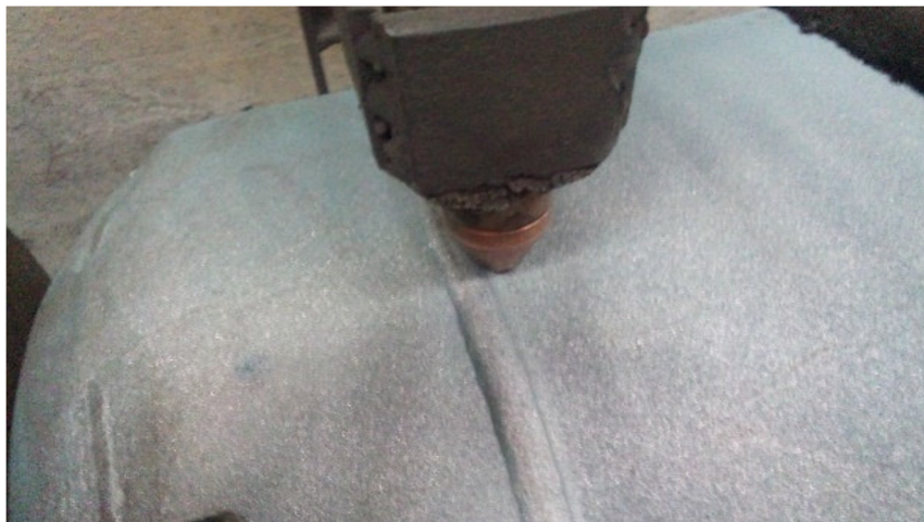
Imagem – Corte da calota avariada ao lado do cordão de solda
