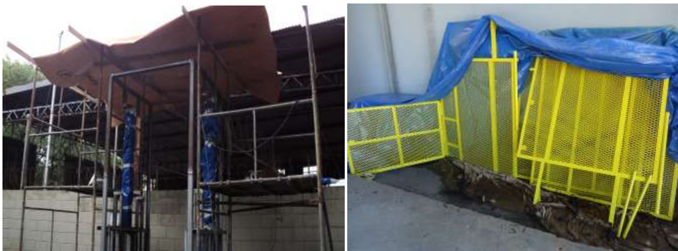
Figuras 7 e 8 – Fabricação e montagem da plataforma;
