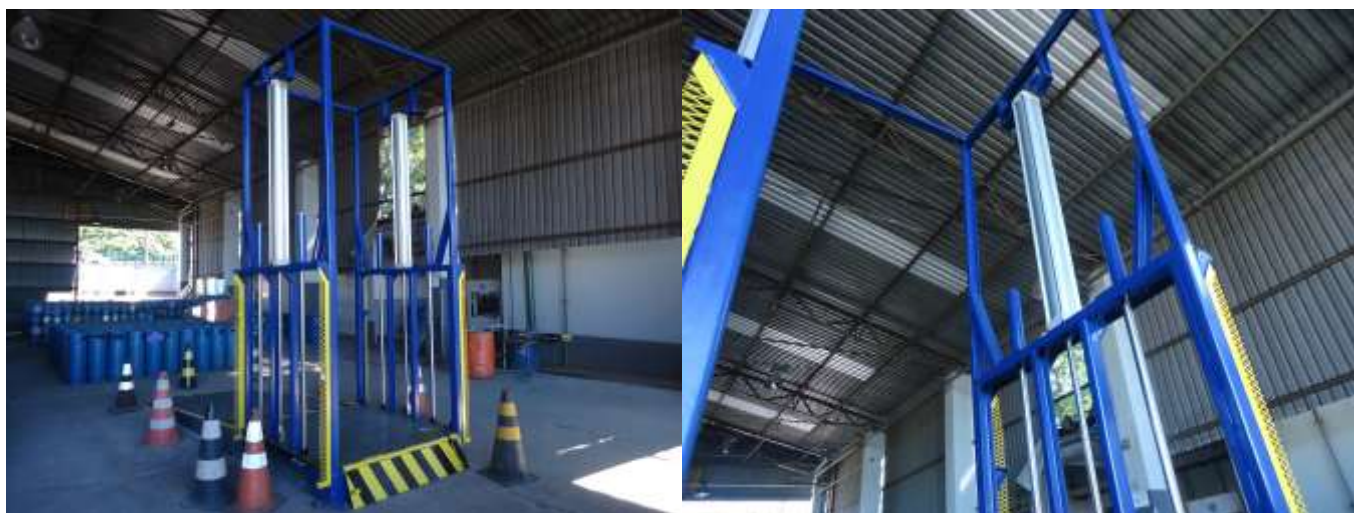
Figuras 11 e 12 – Plataforma instalada no local de movimentação de vasilhames;
