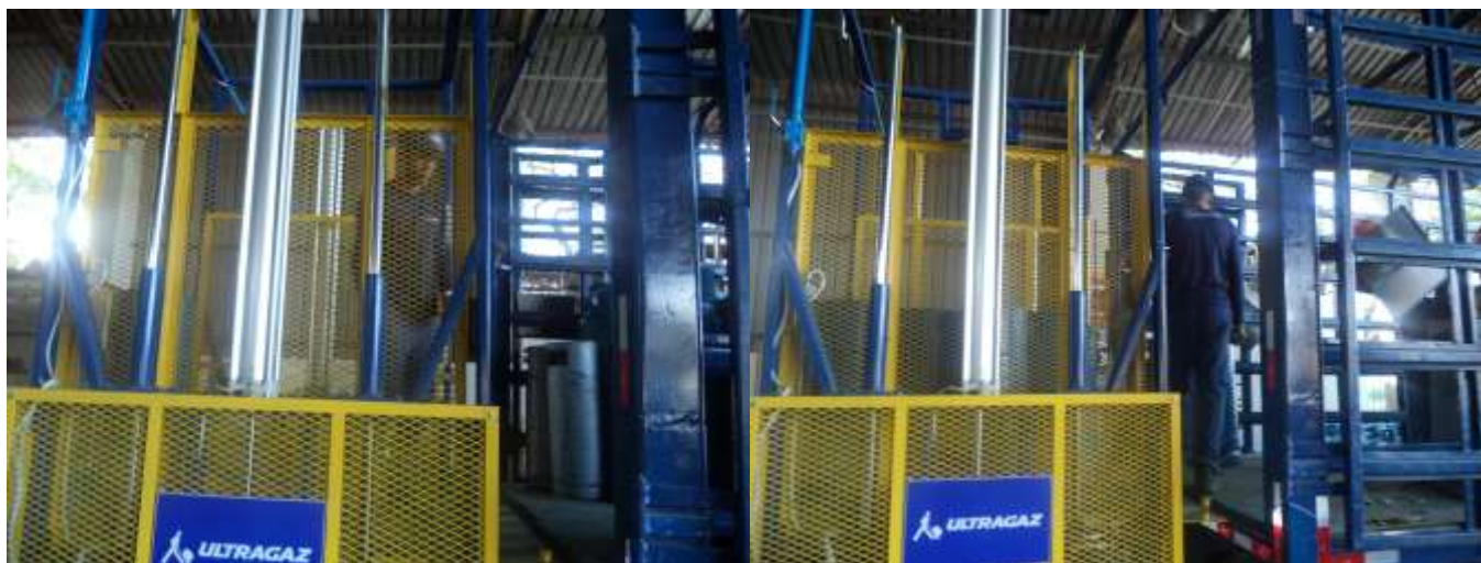
Figuras 21 e 22 – Processo de descarga após a implementação da plataforma;
