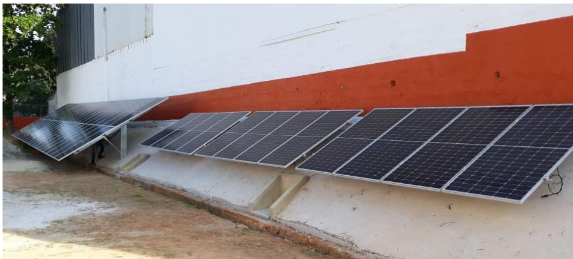
Figura 8: Imagem do talude
