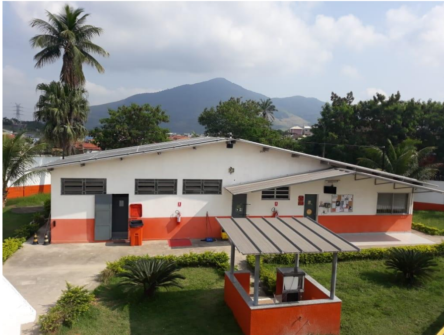
Figura 2: Imagem da Unidade (painéis fotovoltaicos nos telhados)
