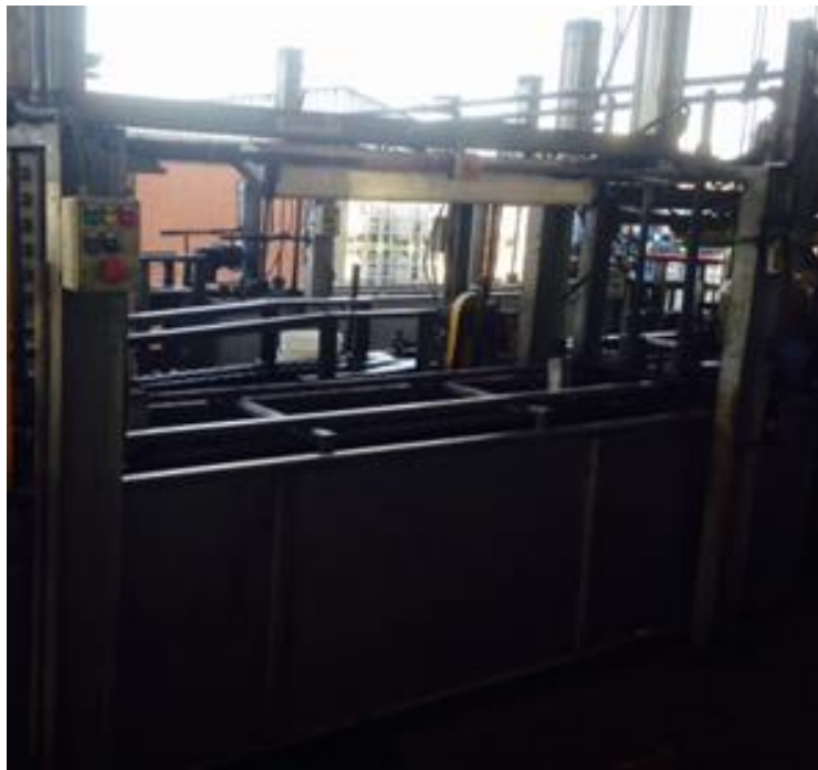
Figura 5 - Tanque de teste de estanqueidade
