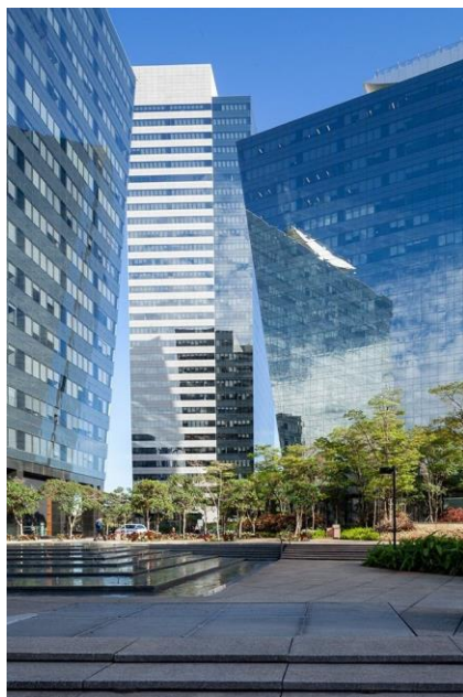
Figura 1 – Matriz Copa Energia - Fonte: Copa Energia S.A.
