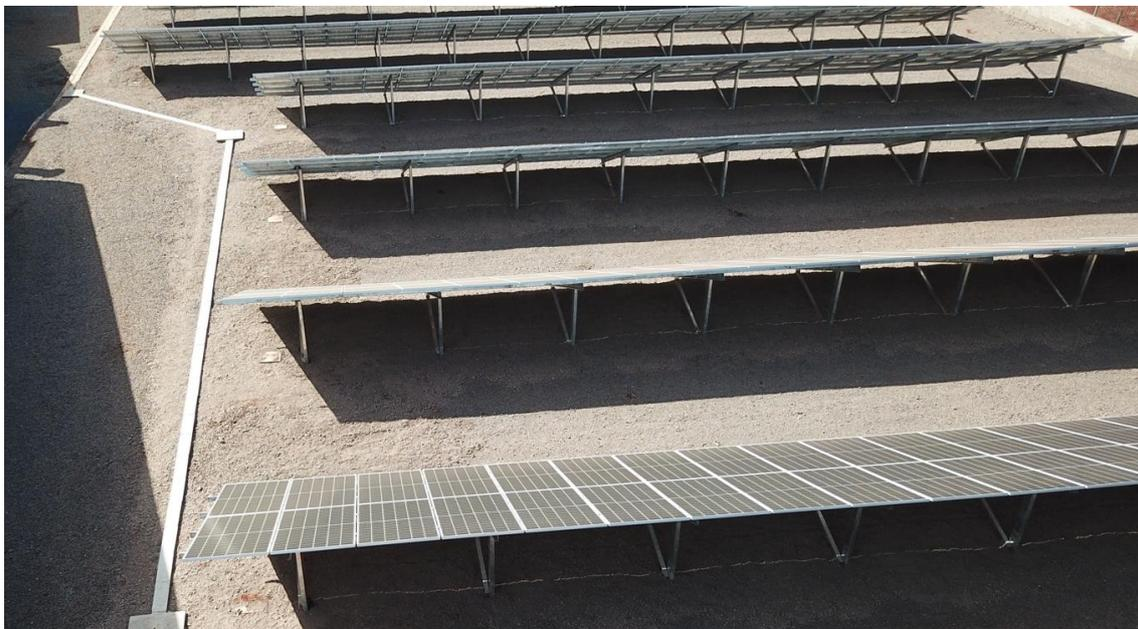
Figura 07 – Placas solares instaladas voltadas ao Norte e com angulação correta.
