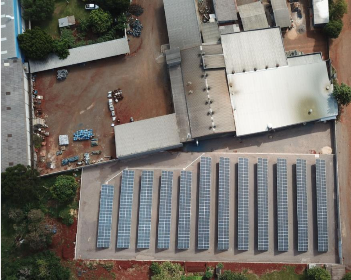
Figura 08 – Instalação das placas solares no terreno ao lado da empresa abastecida com esta energia.
