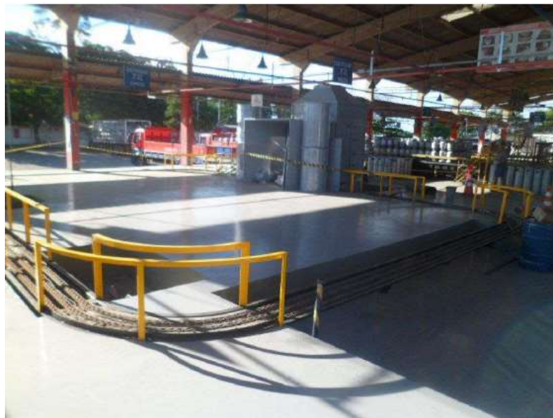
Figura 5: Piso para instalação do carrossel.
