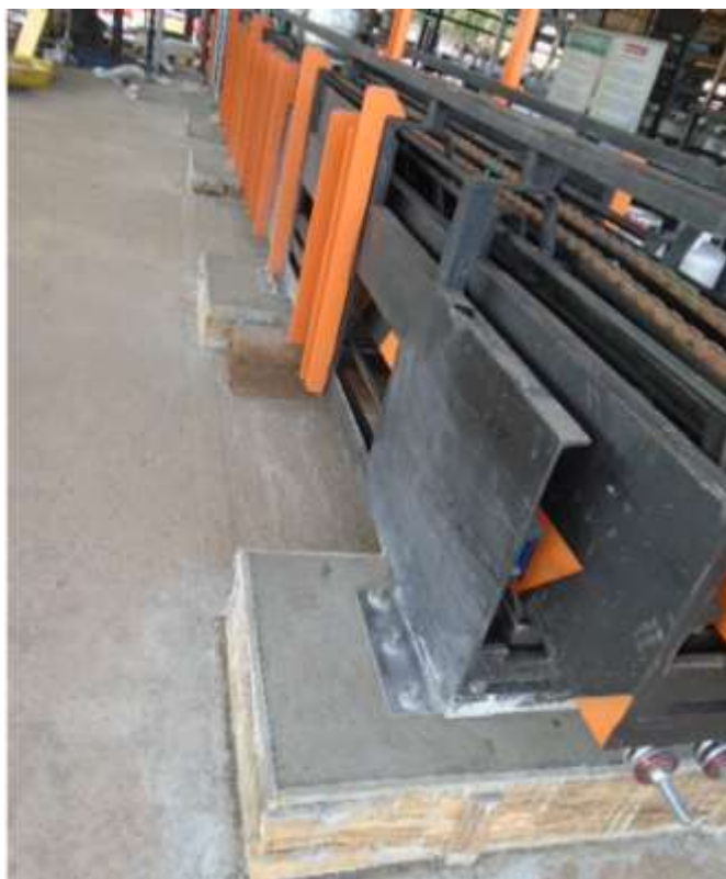
Figura 11: Bases e piso para a instalação da lança telescópica.
