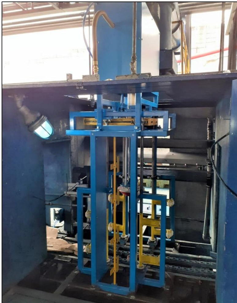
Figura 1: Módulo instalado na base Piloto
