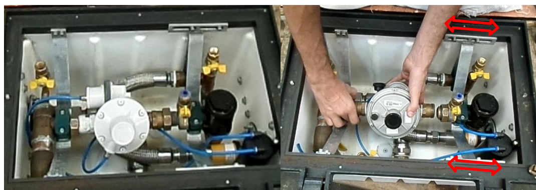
Figura 5 - Substituição dos reguladores
