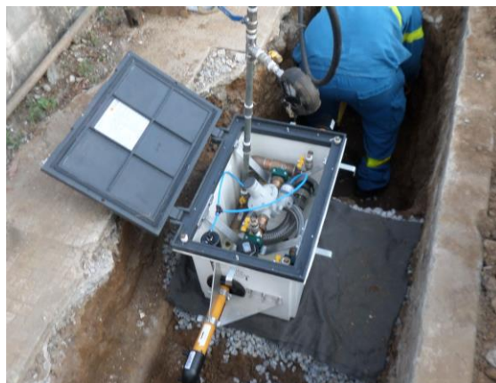
Figura 6 - Acompanhamento da instalação em campo
