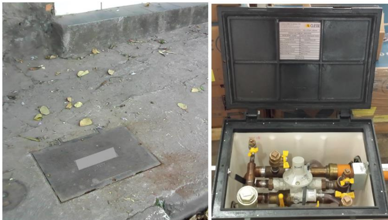
Figura 1 - Conjunto Regulador de Calçada (CRC)
