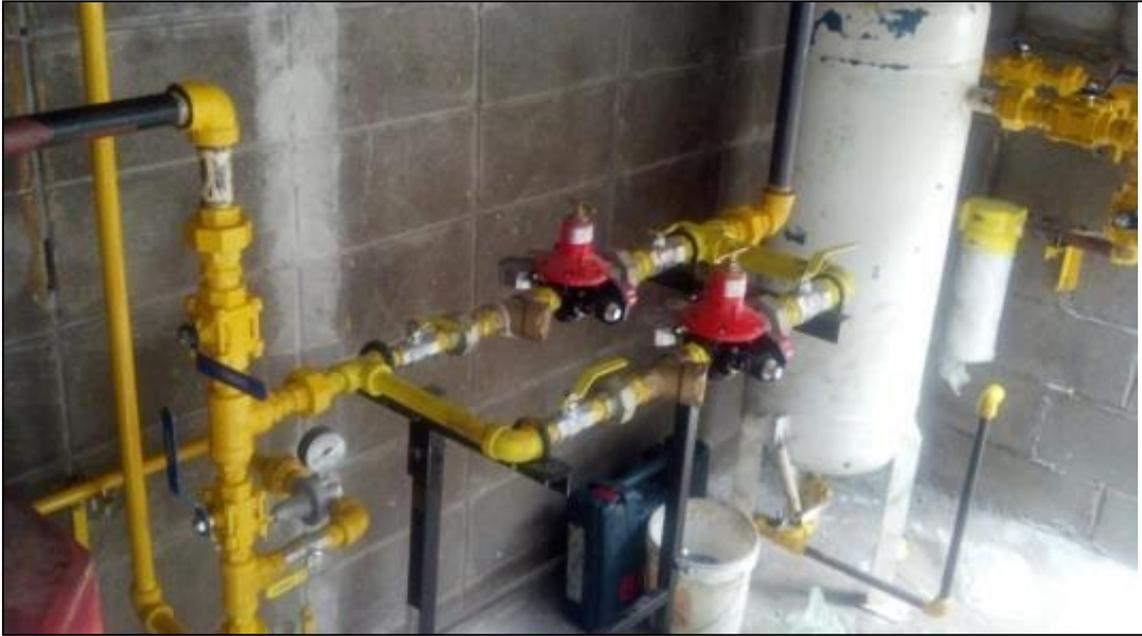
Figura 7 - Instalação de um kit de GLP com skid regulável
