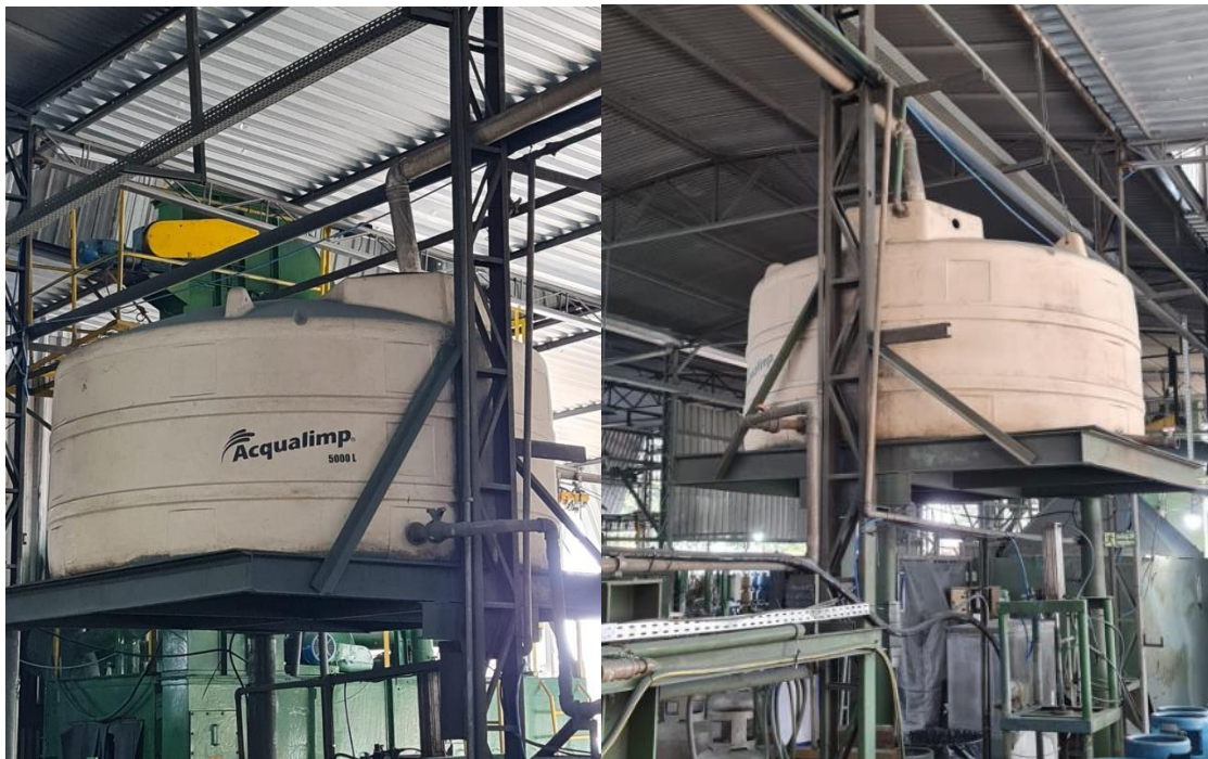
Figura 2 – a) Sistema de coleta e distribuição da água pluvial pelos condutores
