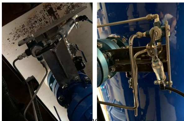
Montagem das tubulações de inox na válvula 3 vias
