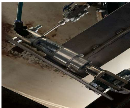
Montagem da válvula 3 vias no suporte parafusado no flange da válvula de fundo
