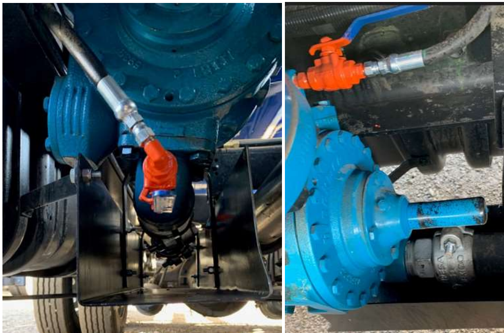
Detalhes das ligações da bomba com as mangueiras flexíveis
