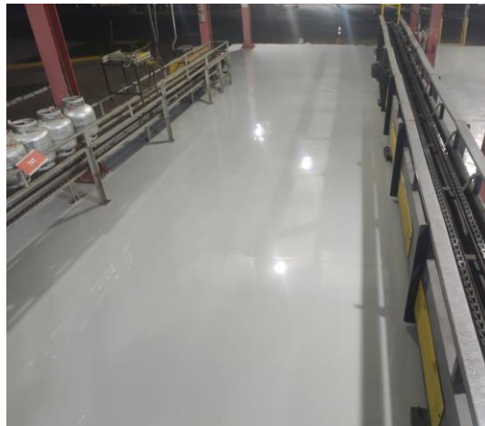
Figura 6 - Aplicação revestimento epóxi
