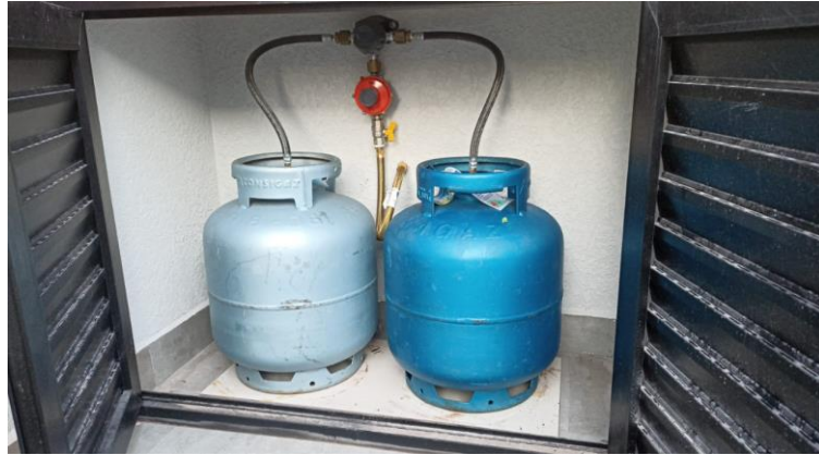
Fig. 09 – Instalação de Kit Inversor em residência com 2 P13
