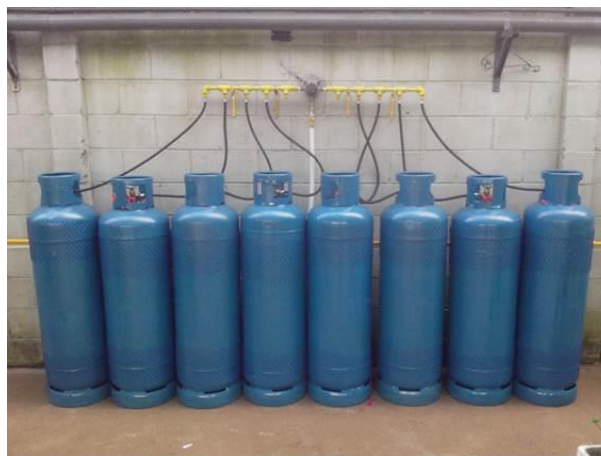
Fig. 08 – Instalação de Inversor em bateria de P45 para sistema de aquecimento de água
