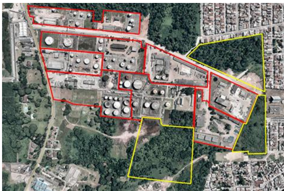
Figura 12 – Áreas portuárias no Terminal Petroquímico de Miramar
