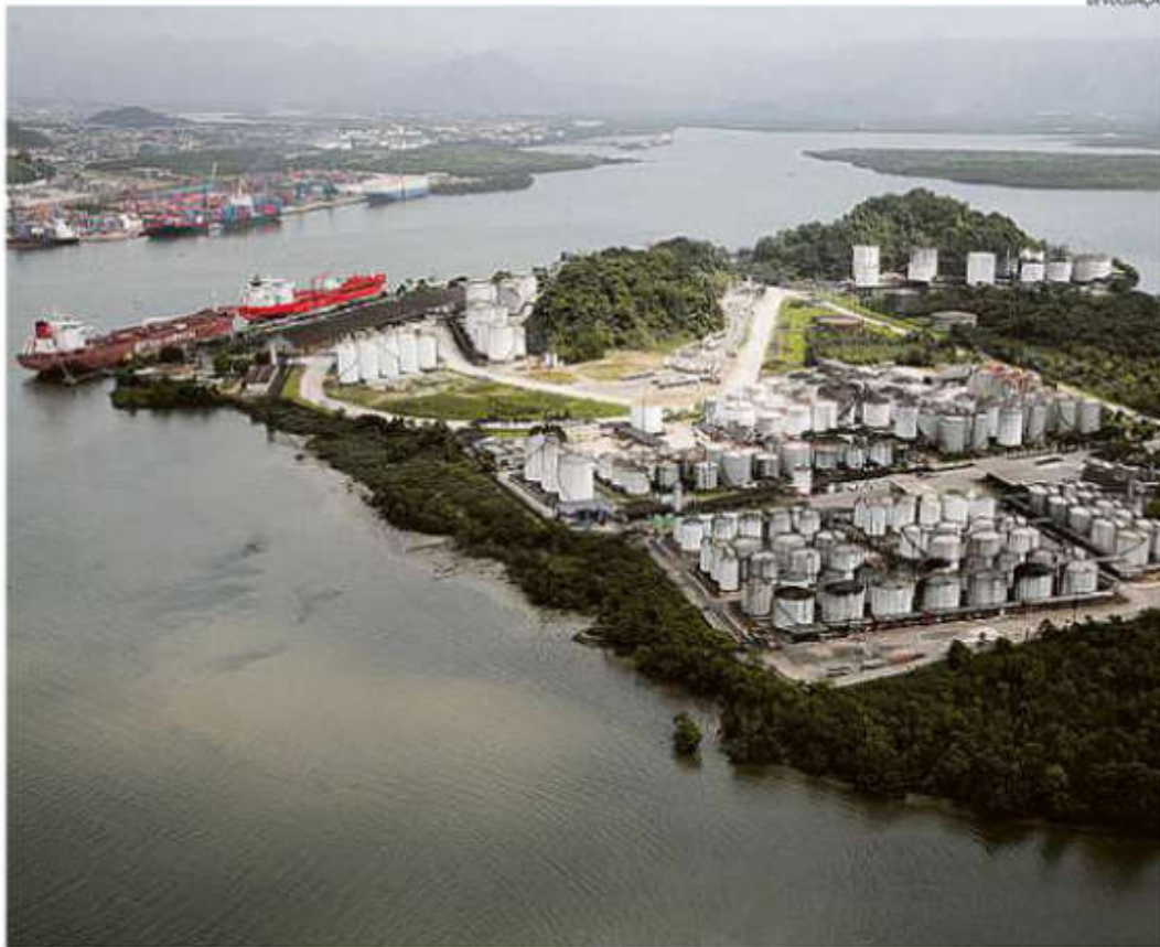
Vista aérea da instalação: quem vencer terá de garantir capacidade estática para 97 mil metros cúbicos de líquidos
